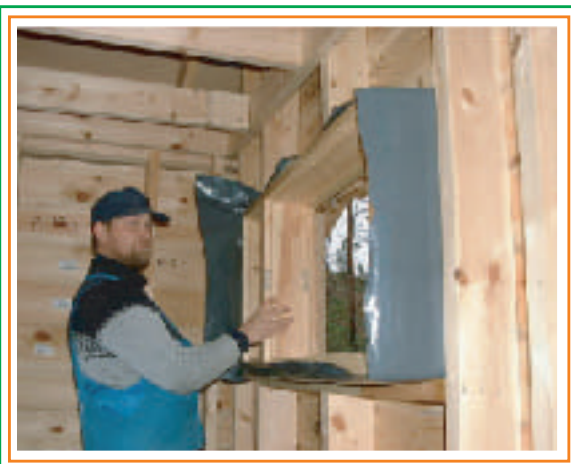
5. Asennetaan ikkuna paikoilleen.
