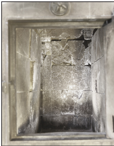
Tulipesä rapautuneena (vas.) ja korjauksen jälkeen (oik.).
