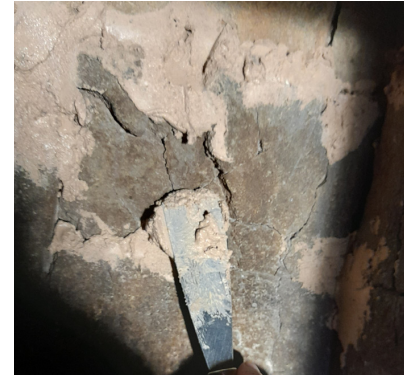
Vaihe 2: Vahvista tiilimuurauksen saumat Pesäkorjausmassalla.
