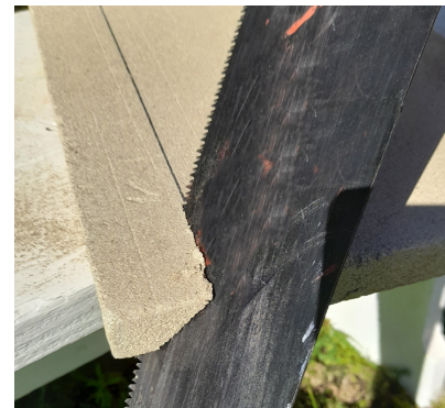
Vaihe 4: Pehmeää vermikuliittilevyä voi sahata tavallisella sahalla.
