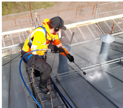
2. Siisti pelti puhdistuu painepesussa pelkällä vedellä.
