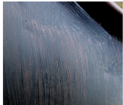
5. Pohjamaali kuultaa hieman ensimmäisen pintamaalikerroksen läpi, vasta toinen kerros tekee maalikalvosta peittävän.
