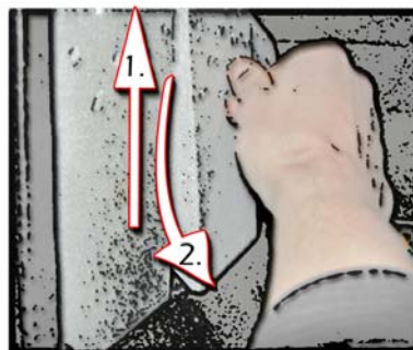
3. Lyft stenen uppåt ca 5-7 mm med hjälp av skruvmejseln. Släpp sedan ned stenen något och vinkla in nederkanten in mot eldstaden och släpp sedan ned den hel & hållet.
