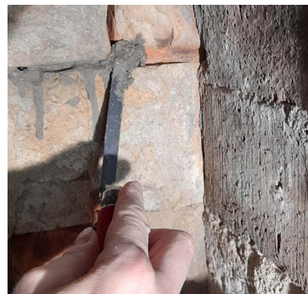
Vaihe 5: Levitä laasti saumoihin ja koloihin.
