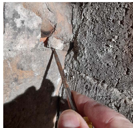
Vaihe 1: Poista irtoneiset kappaleet ja pehmeä laasti.
