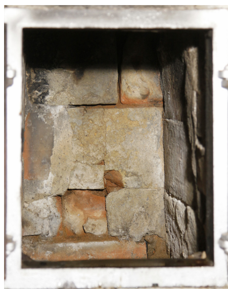
Tulipesän takaseinä ennen (vas.) ja jälkeen (oik.) korjauksen.
